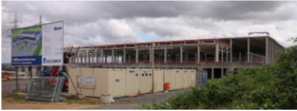
Die Arbeiten am neuen Distributionscenter der Bona GmbH sind in vollem Gang. Einige Teile des Gebäudes sind bereits errichtet, sodass aktuell Dach- sowie Fassadenarbeiten ausgeführt werden.
